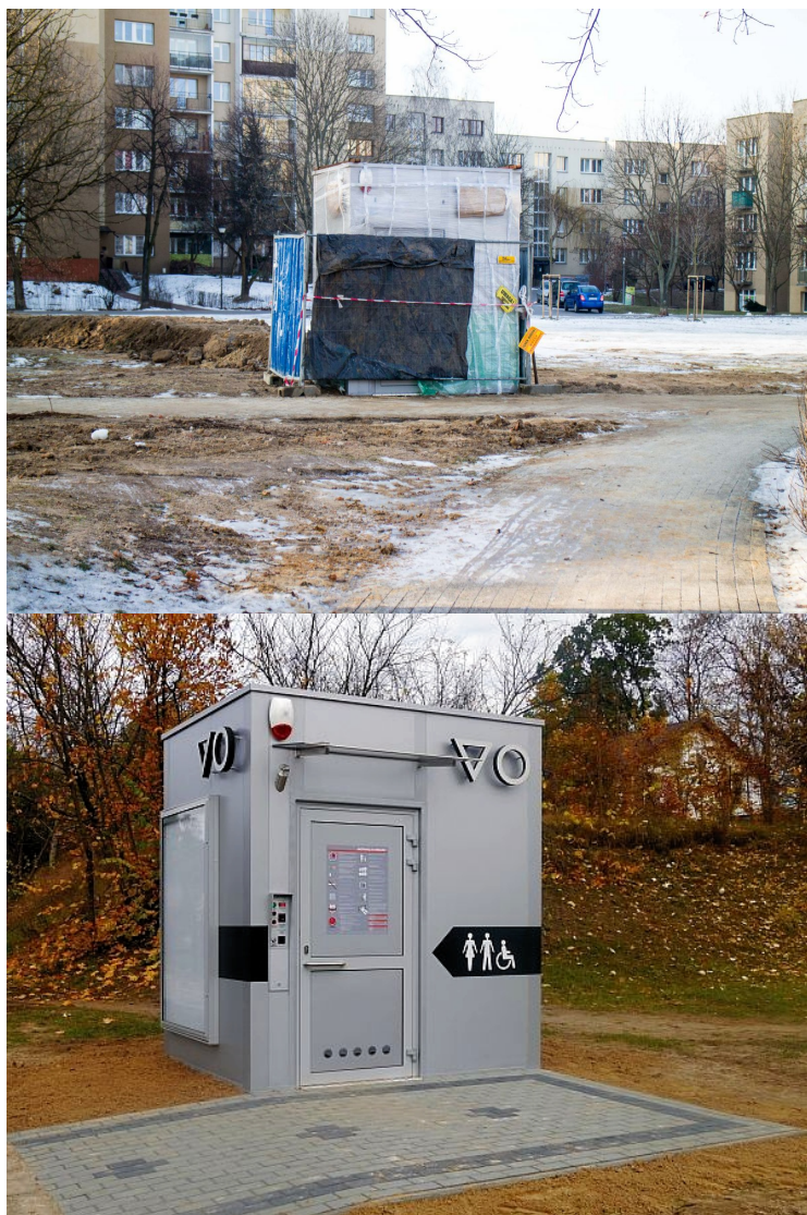
powyżej: toaleta na Olkówku - jeszcze nie podłączona; obok działająca toaleta, foto: Budotechnika
